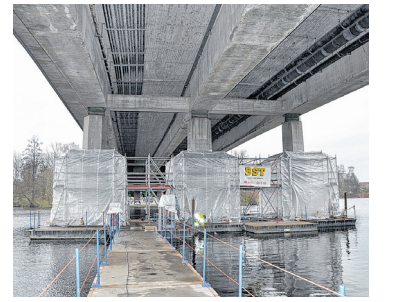
Kommende Woche werden die Pfeiler betoniert. FOTO: KRÖGER
